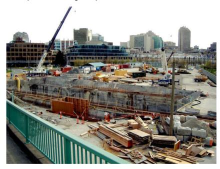
Figure 3-2: Exemple de construction en tranchée couverte - Skytrain de Vancouver (1)
