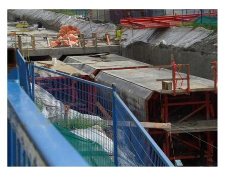
Figure 3-3 : Exemple de construction en tranchée couverte - Skytrain de Vancouver (2)
