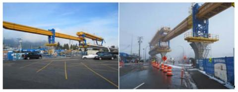
Figure 3-1 : Technique envisagée pour la pose des voussoirs
