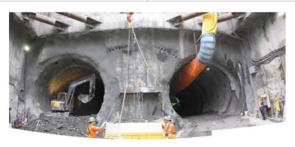
Figure 3-12: Technique d'excavation conventionnelle à partir du puits
