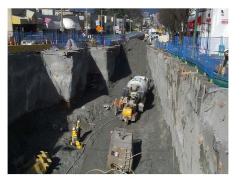
Figure 3-5: Exemple de construction en tranchée couverte - Skytrain de Vancouver (4)
