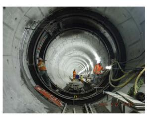
Figure 3-10 : Technique d'étanchement - Consolidation du sol à partir du tunnel
