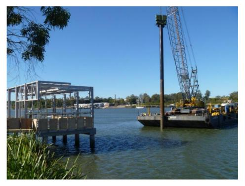
Figure 3-15: Exemple de construction avec barge pour forage de pieu (Northshore, Hamilton)
