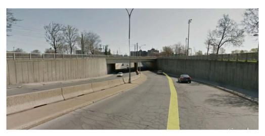
Figure 2-15 : Exemple d'étagement inférieur de la route sous la voie ferrée
